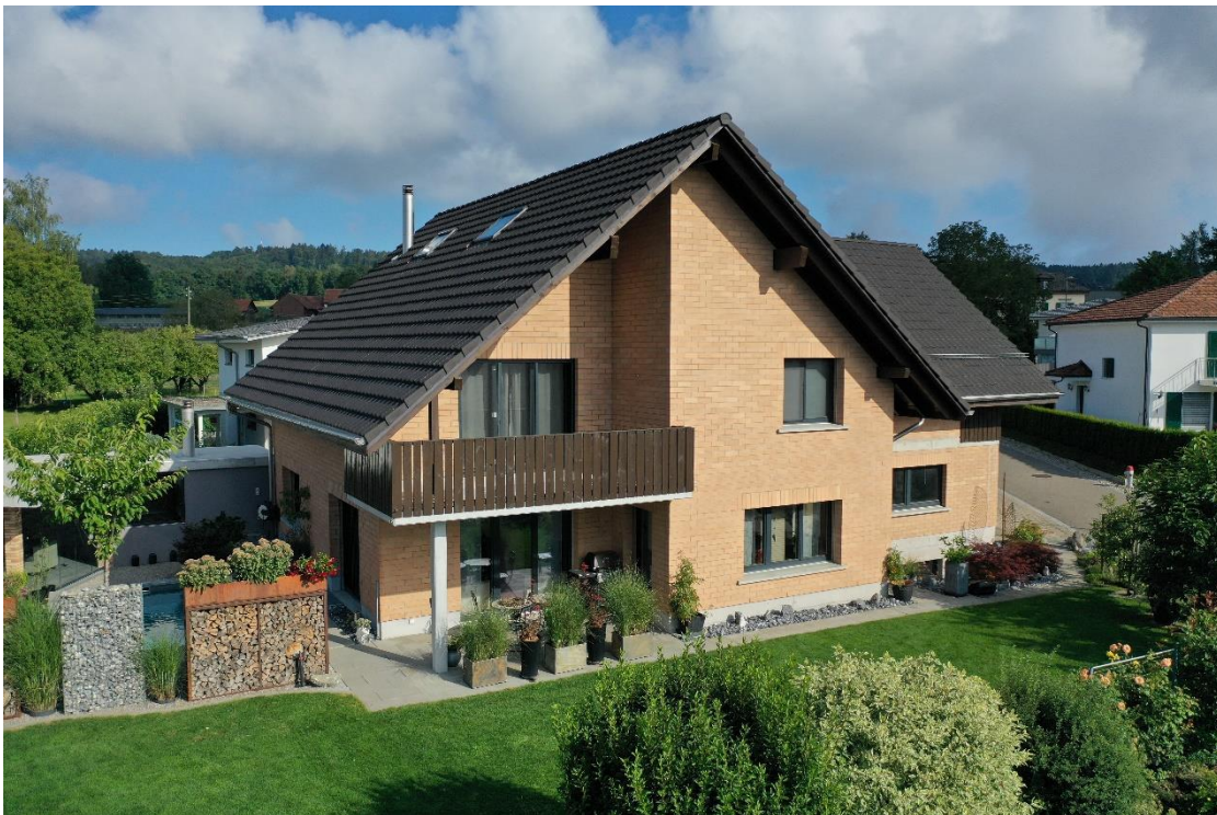
EFH mit Monoklinker System ausgeführt
